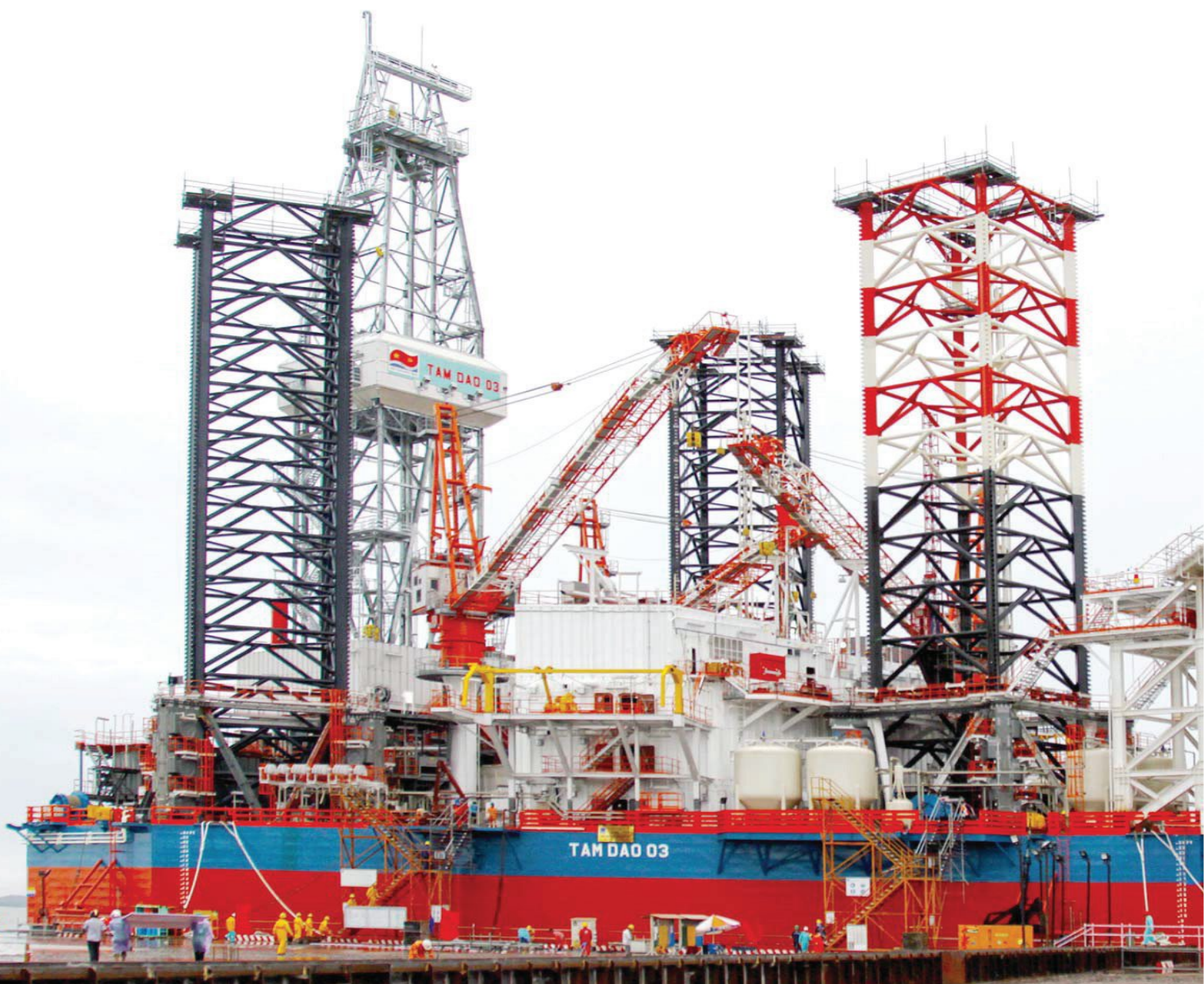
Giàn tự nâng Tam Đảo 03 Tam Dao 03 Self-jacking platform
