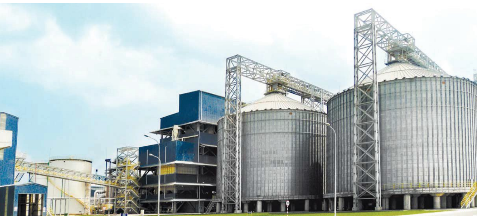
Lắp đặt thiết bị cơ, điện - Nhà máy nghiền đậu nành Bunge M, E, I & C installation - Bunge soya crushing plant
