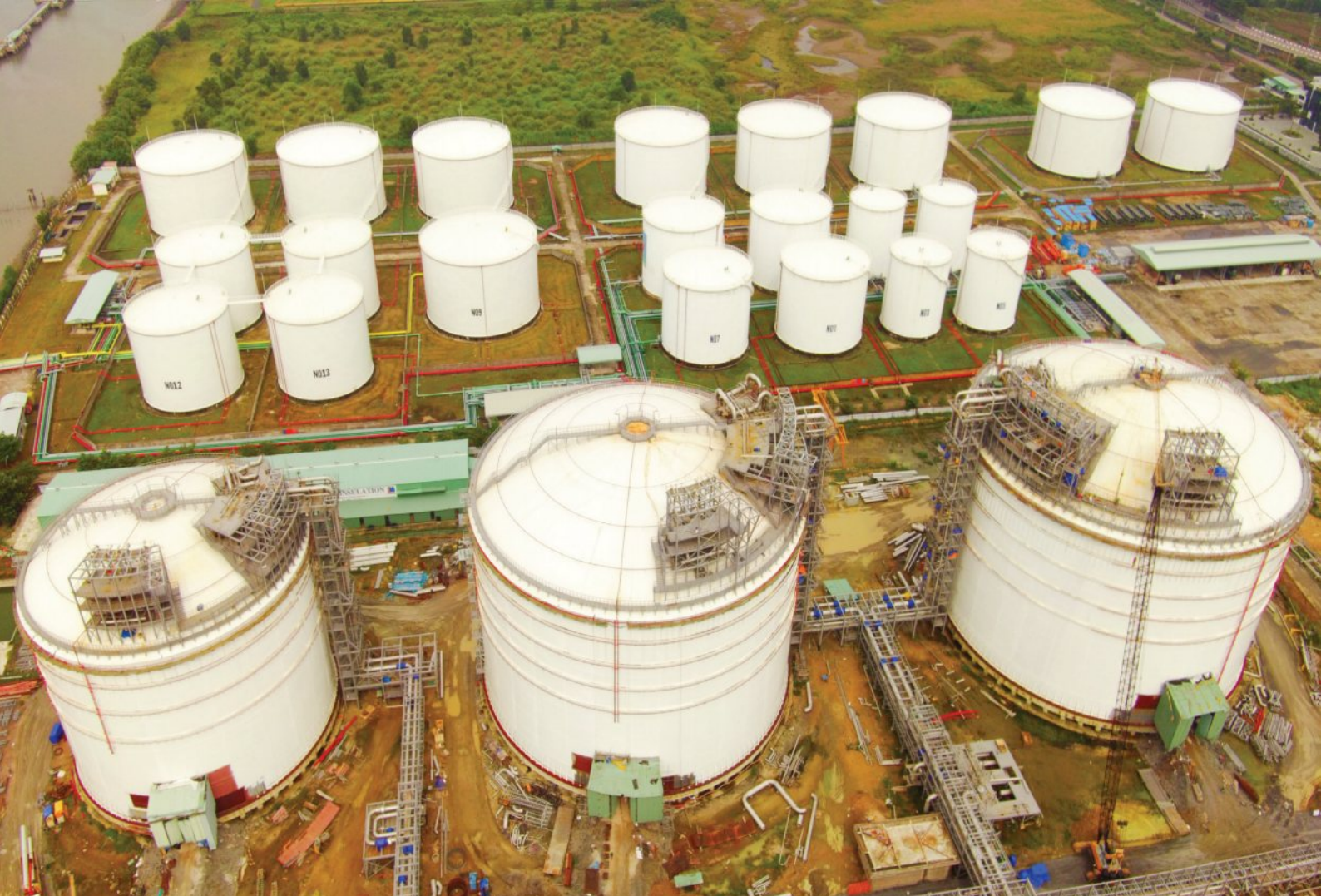
Gia công, lắp đặt bồn 2 lớp chứa LNG - Kho Hải Linh Fabrication, installation of LNG double wall tanks - Hai Linh terminal
